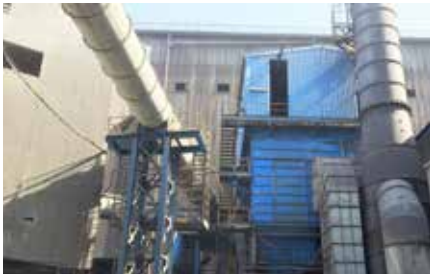
Kükürt Giderme Tesisine Yeni Toz Toplama Sisteminin Yapılması
