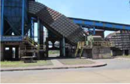
4. Yüksek Fırın Şarj Tesisi Toz Toplama Sistemine Silobus Toz Boşaltma Sistemi Kurulması
