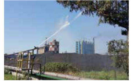
Kok fabrikası Toz Kok Stok Sahasına Yağmurlama Sistemi Yapılması
